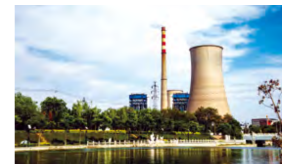
河北唐山热电公司机组三项污染物排放浓度平均值为二氧化硫 18.21 毫克 / 标立方米、氮氧化物 28.51 毫克 / 标立方米、烟尘 2.10 毫克 / 标立方米，远低于国家超低排放标准。
