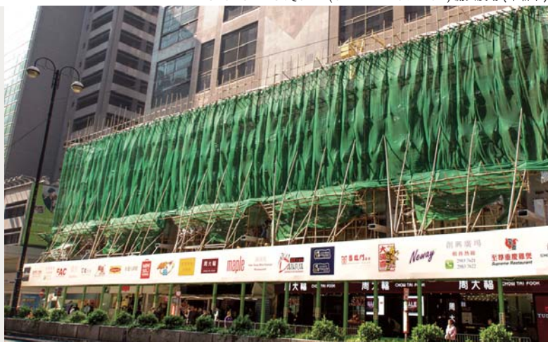
CHONG HING SQUARE ( UNDER RENOVATION ) 創興廣場 (革新中)
