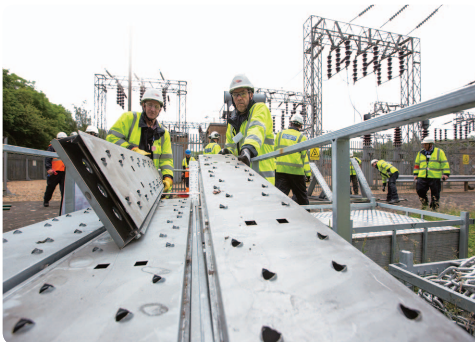
在配電網絡工地工作的 UKPN 員工致力維持電網的可靠運作。
