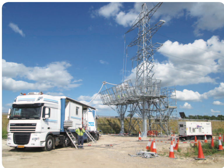
UKPN 在 M1 高速公路進行電纜支線工程。
