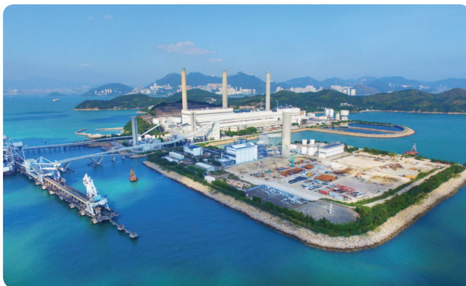
港燈正在南丫發電廠興建新的燃氣發電機組。
