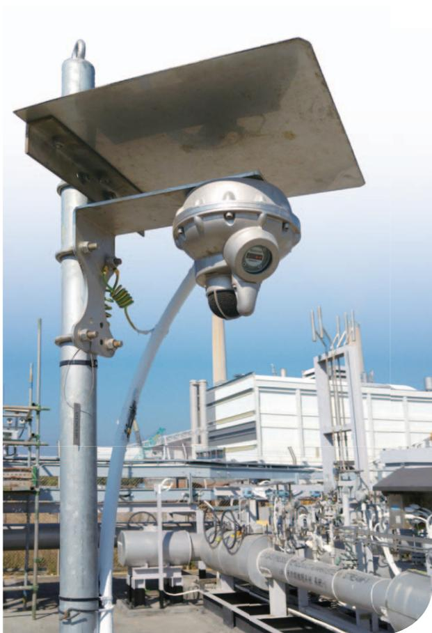
南丫發電廠安裝聲學感應器提升設施的安全度。
