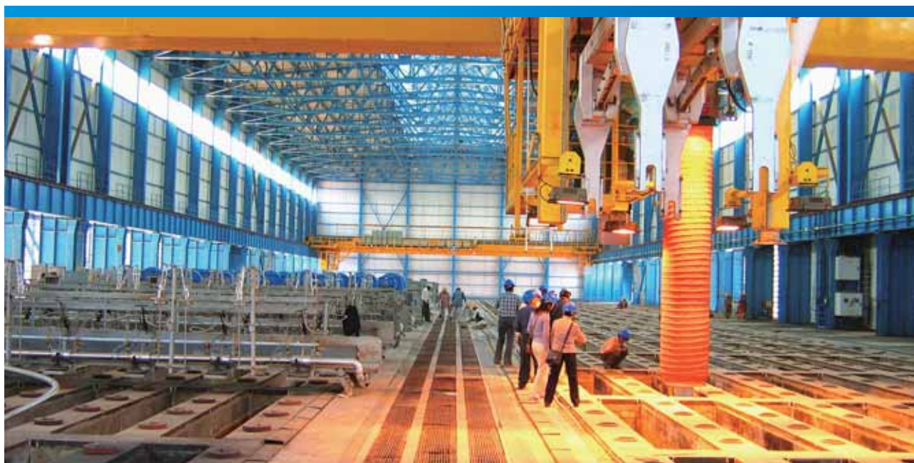
印度 BALCO 陽極焙燒爐
