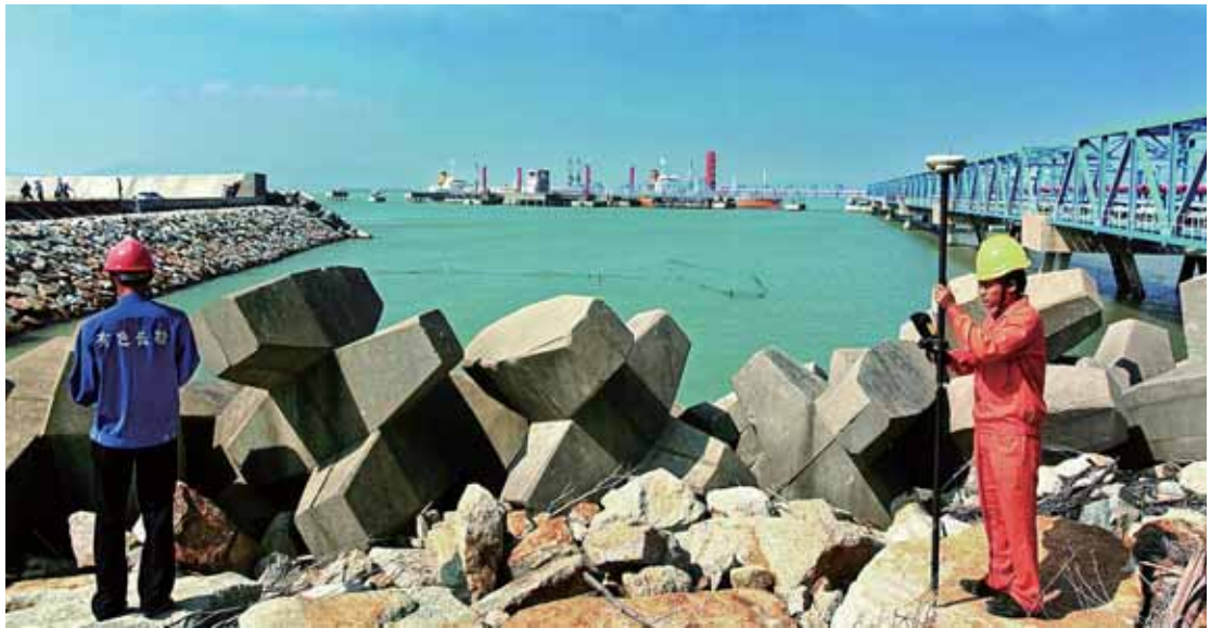
珠海高欄港區航道沉降觀測項目
