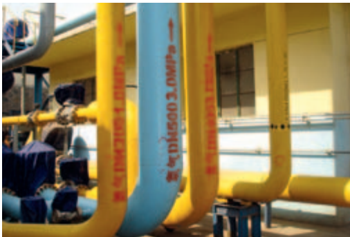
開展防腐工程
