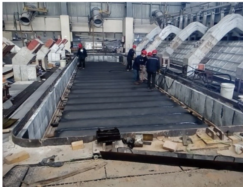
鄭州研究院開發的新型穩流保溫鋁電解槽節能技術
