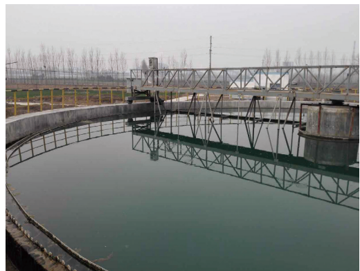
中州鋁業一體化淨水廠斜板式沉澱池
