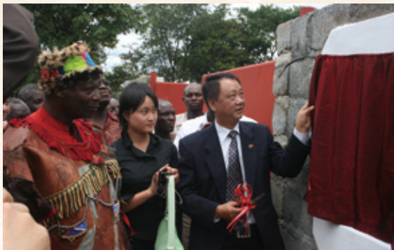
捐建的贊比亞圍牆竣工揭牌。
