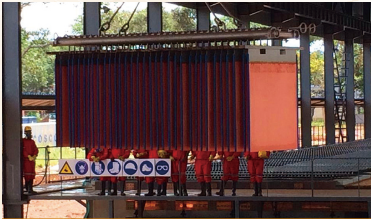
馬本德項目工人吊裝陰極銅產品
