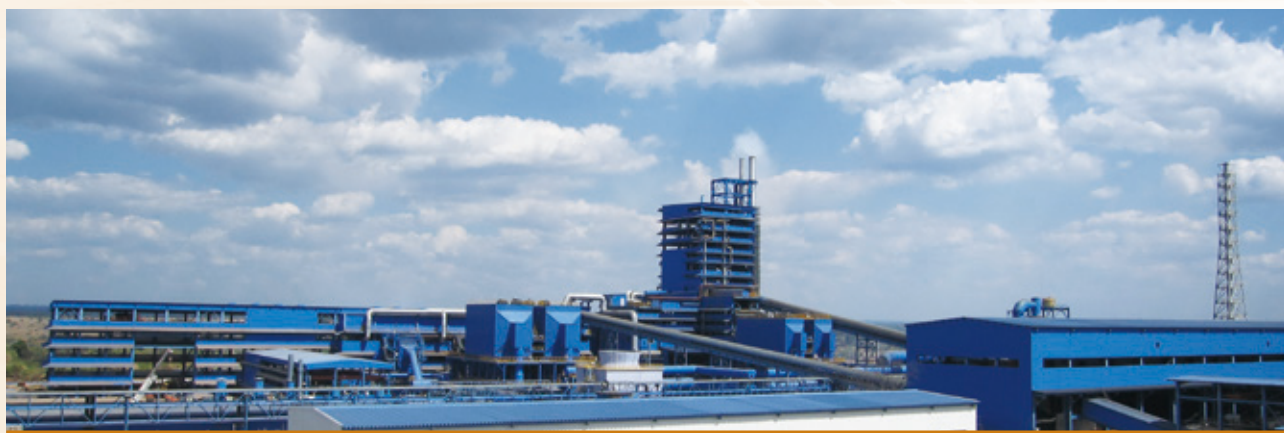
銅冶煉公司廠房全景
