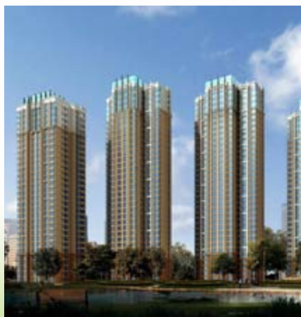
■ 富豪新開門之住宅大樓 — 上蓋工程接近完成(*)
