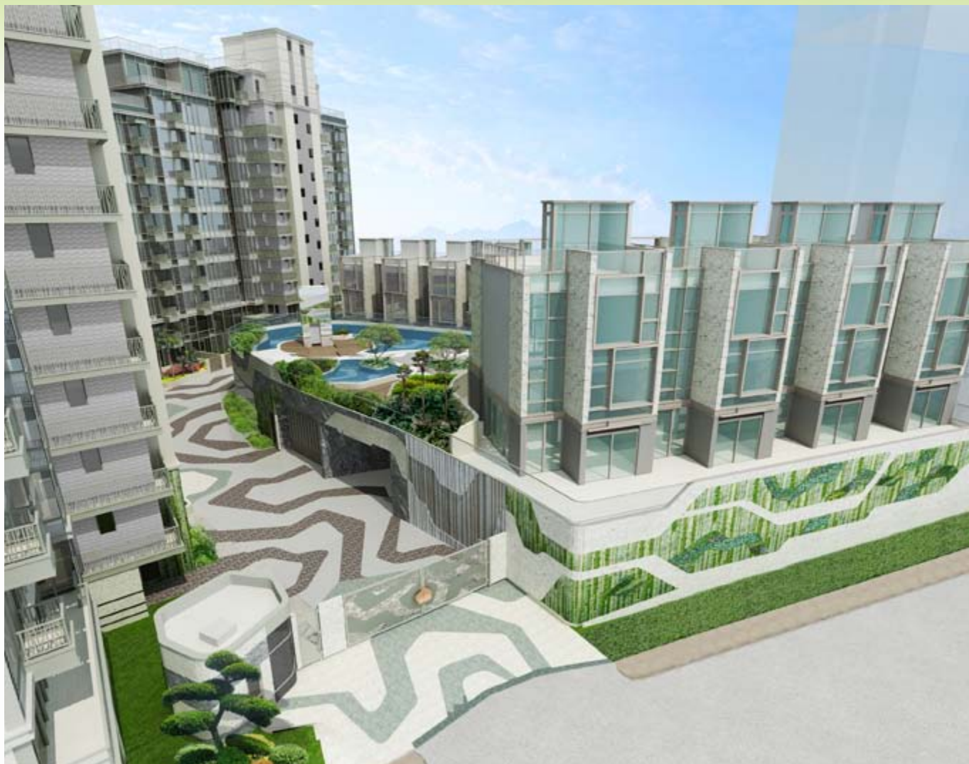
■ 位於新界沙田九肚第56A區沙田市地段第578號之豪華住宅發展項目 – 上蓋建築工程進行中(*)
