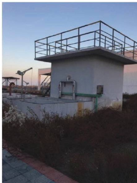
污水站—污泥槽
