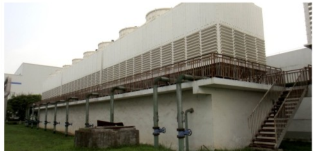
透平循環水泵房(小機試車)
