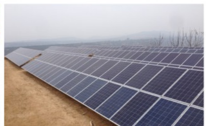
吉縣光伏扶貧項目建設
