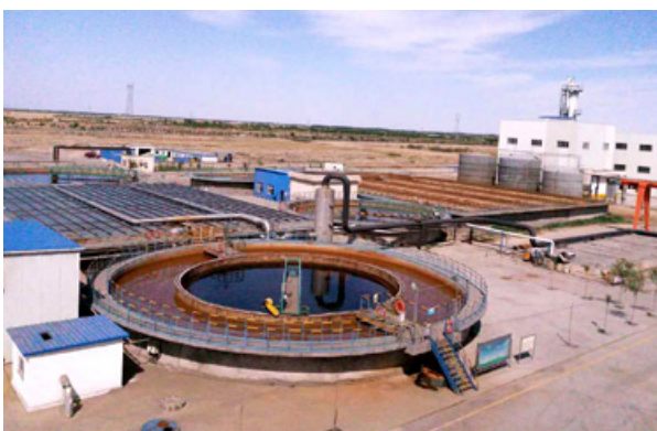
廢水兩級AO處理系統
