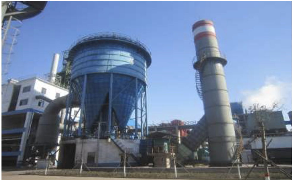
圖2 高爐礦槽除塵系統
