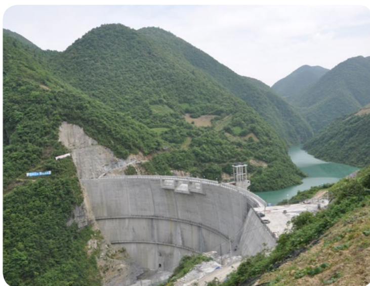
巫山縣千丈岩梯級電站
