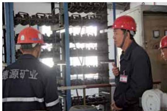
西藏華泰龍對4620斜井卷揚室機電區檢查
