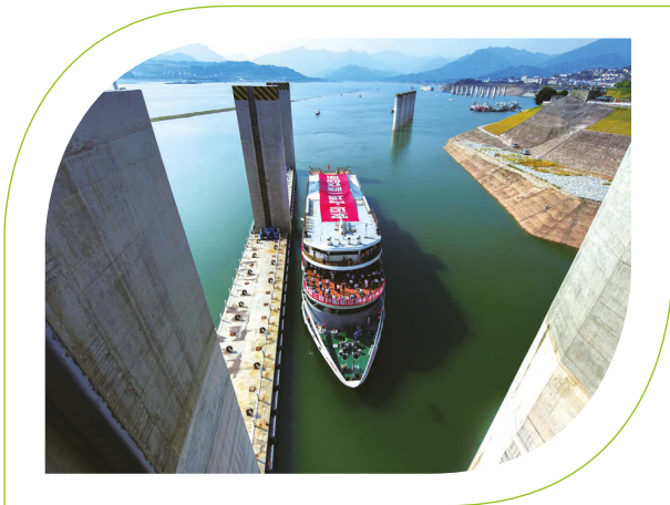
葛洲壩三峽建設公司承建的 世界最大升船機通過驗收
