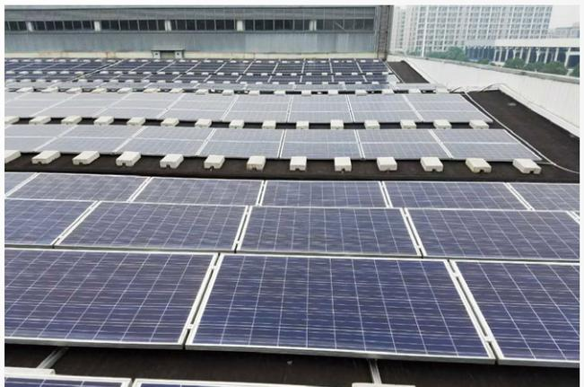
雅迪還積極開拓新能源的使用。報告期內，雅迪已於無錫建成旗下其中一所最大的自置光伏發電廠，能夠生產並配送電力。於無錫總部、研發大樓、行政辦公樓連同若干部門大樓的樓頂均裝有裝機容量達2.48兆瓦高效能多晶PV模塊。預計於第一年啟用將產生總電量約2.57百萬千瓦時。
