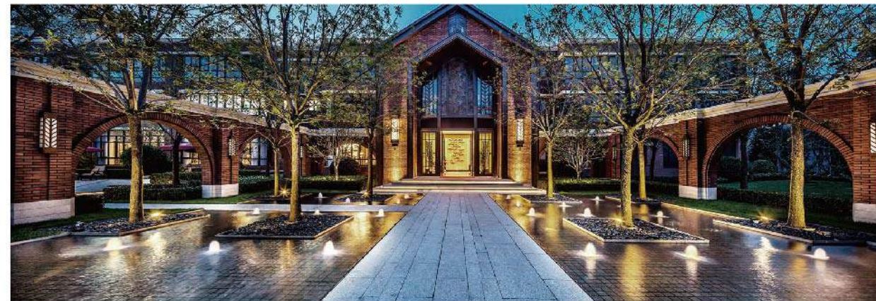
北京首开华润城项目
