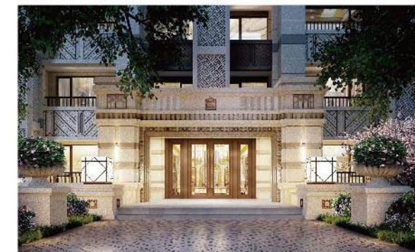
北京首开华润城项目
