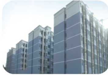
城市基礎設施建設
