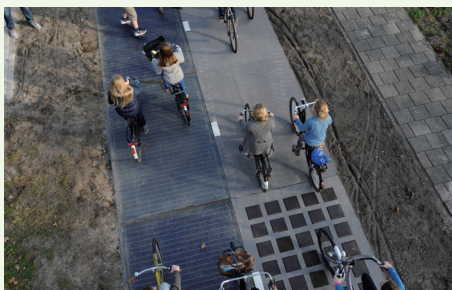
The world’s first solar bicycle lane 世界上第一條太陽能自行車道
