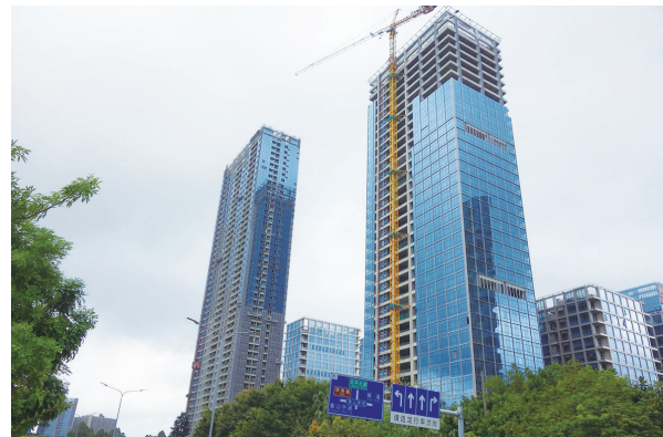
僑城坊 — 正進行裝修工程
