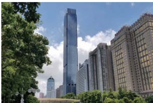
漢國城市商業中心 – 正處於工程竣工階段
