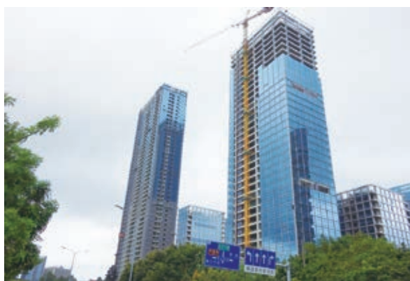
僑城坊 – 正進行裝修工程
