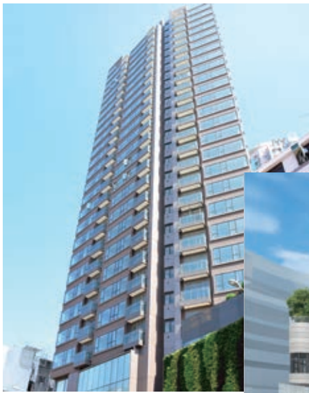
承建主要合約工程－位於九龍城之住宅發展項目
