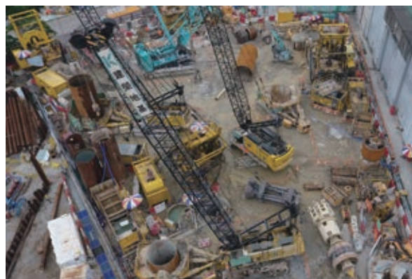
日出康城之地基打樁工程
