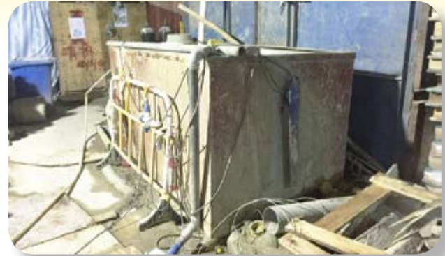
建築地盤的污水處理設施
