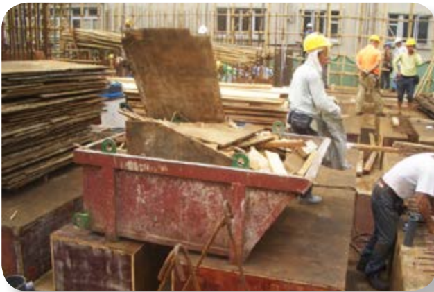
於建築地盤回收木材再用
