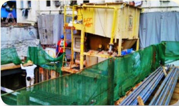
建築地盤的污水處理設施
