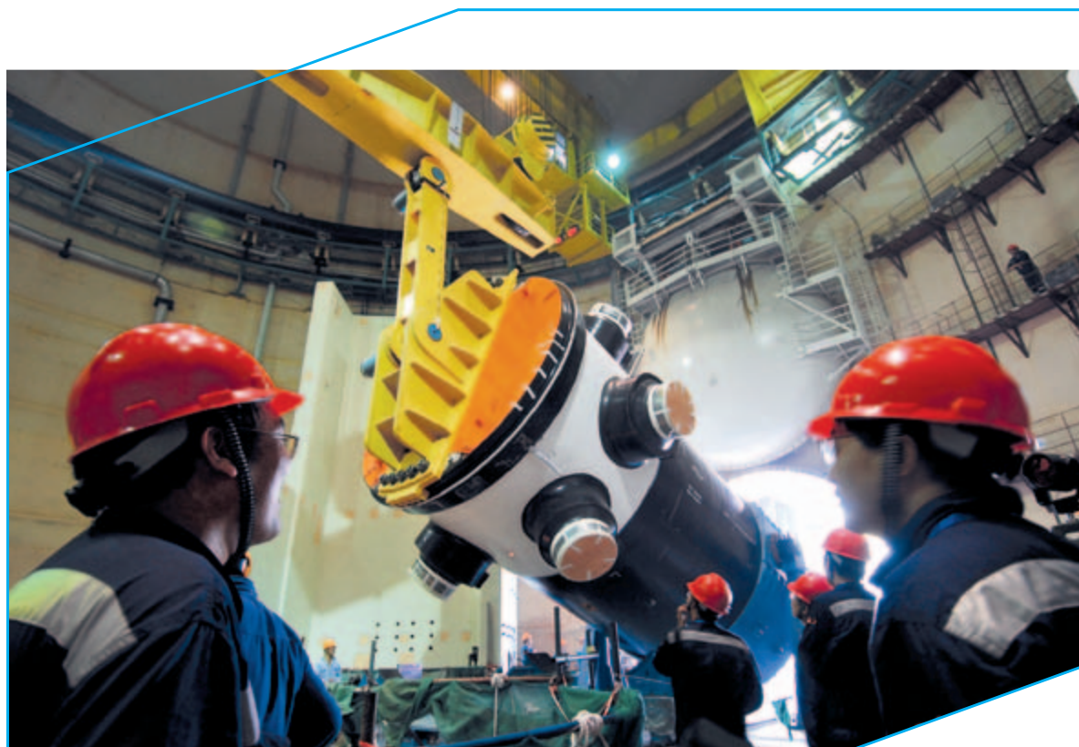
工程人員進行設備吊裝
