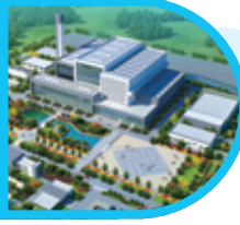
陸豐垃圾焚燒發電廠
