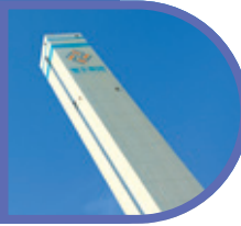
清遠垃圾焚燒發電廠
