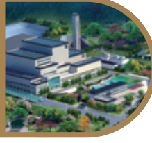
信宜垃圾焚燒發電廠
