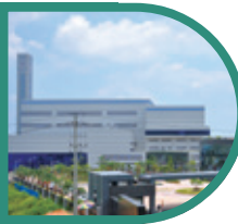
湛江垃圾焚燒發電廠
