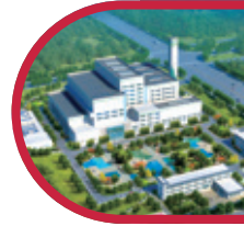
北流垃圾焚燒發電廠
