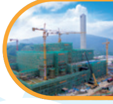
東莞粵豐垃圾焚燒發電廠二期
