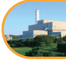
科維垃圾焚燒發電廠
