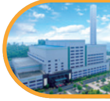
東莞粵豐垃圾焚燒發電廠一期
