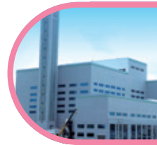
來賓垃圾焚燒發電廠
