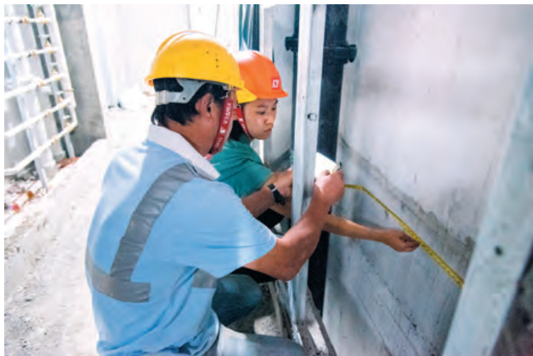
集團員工詳細檢查和監督項目，有助確保施工質素
