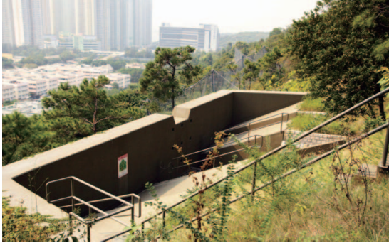
建造擋土牆及安裝泥石流剛性防護網
