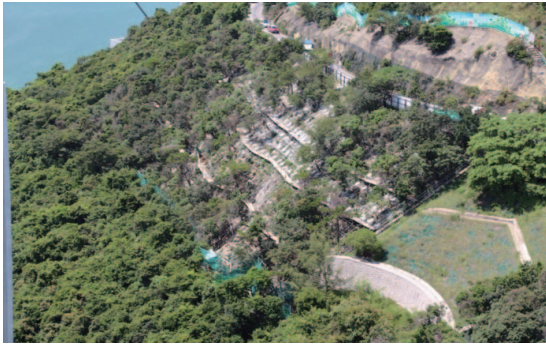
安裝土釘、侵蝕防治及 金屬絲網、維護樓梯
