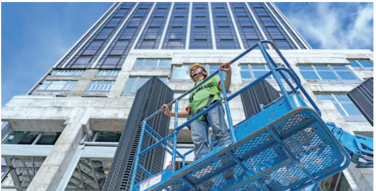
新世界建築有限公司承建的新世界中心重建項目
