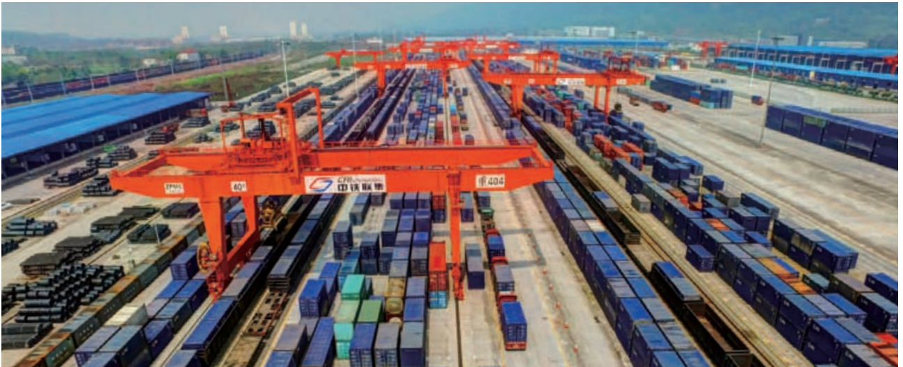
重慶鐵路集裝箱中心站
