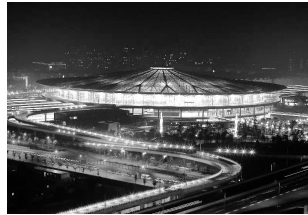
上海鐵路南站 城市動力廣場
