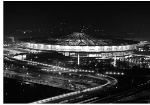
上海鐵路南站 城市動力廣場
