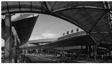
虹橋機場東交通中心 (公交站區)
