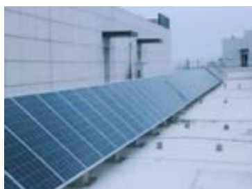
智慧大廈屋頂不透光多晶硅光伏面板
