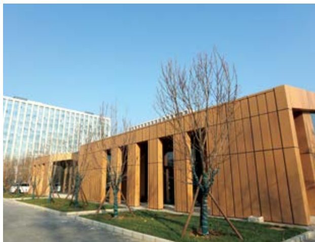
公司北京總部二期園區汙水處理系統
