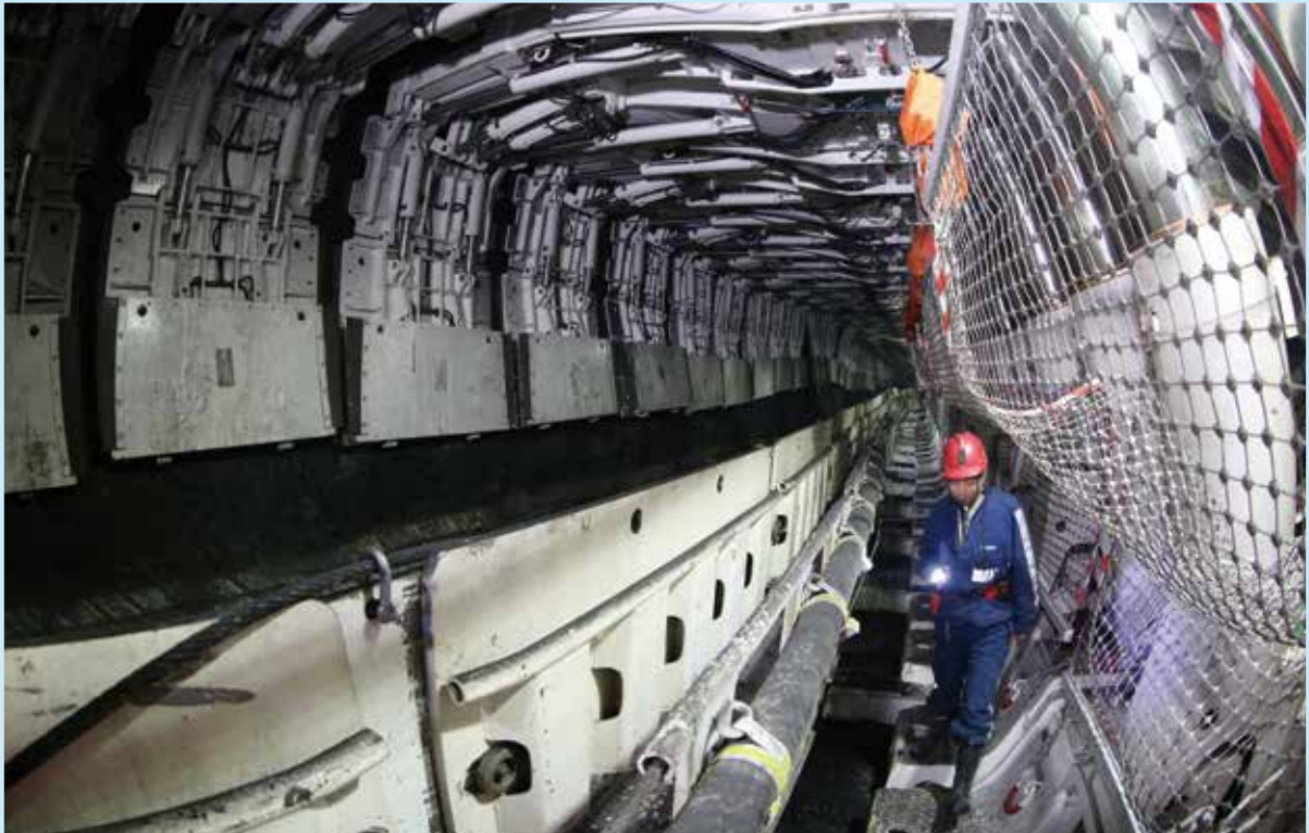
2017年1月，8米大採高整裝設備通過運輸通道被順利運輸到井下投入生產，使這項工程成為了現代煤炭行業礦井建設上的一項「超級工程」
