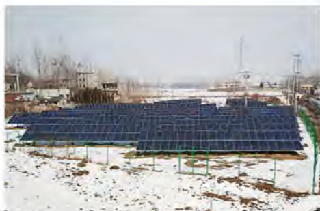
合肥分行“光伏發電站”專案
