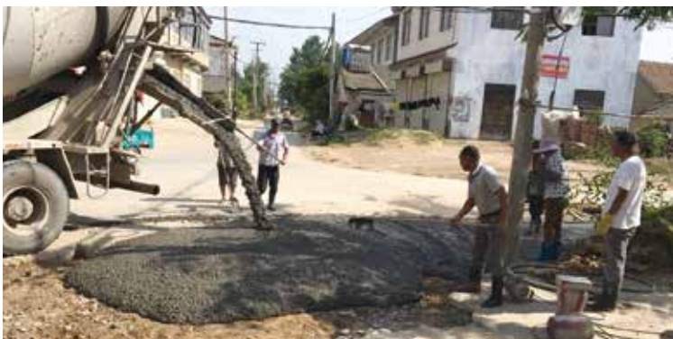
紅樓村路面修建
