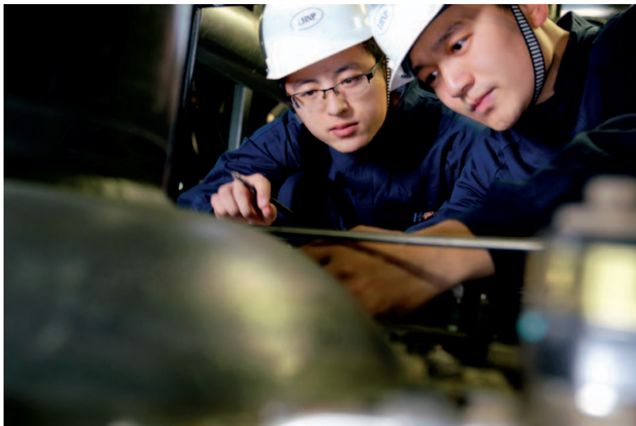
工程師開展現場檢修工作
