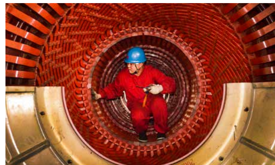
河北张家口发电厂开展设备检修
