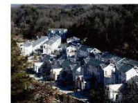
◀ 洛阳铝业支持栾川镇的公共住房建设项目
