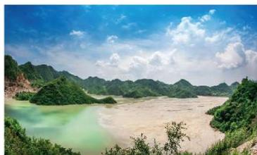
▲ 在中国，我们的生产用水通过尾矿库沉淀后实现全部循环利用，再生产过程中仅需补充少量河道水。尾矿澄清水是选矿过程中产生的生产废水，经砂浆泵送至尾矿库，在尾矿库稀释、澄清后经回路回水管道100%循环使用。清洗生产设备水源均来源于尾矿库澄清水，经用水管道架送到各个使用点对设备、生产场地进行冲洗、清洁。冲洗后的废水经车间的各条排水沟，渠汇集到排尾车间事故池或车间内部的尾矿池集中，排尾车间对收集后的废水经砂浆泵输送到浓密池，由排尾车间往复泵输送至尾矿库。
