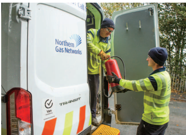
NGN 的工程師在布拉德福德 (Bradford) 一條總氣體管道進行工程，以維持供氣網絡的可靠運作。
