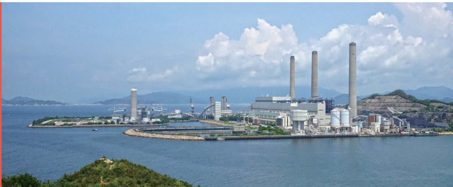
港燈的南丫發電廠正在興建新基礎設施，以提高燃氣發電量。
