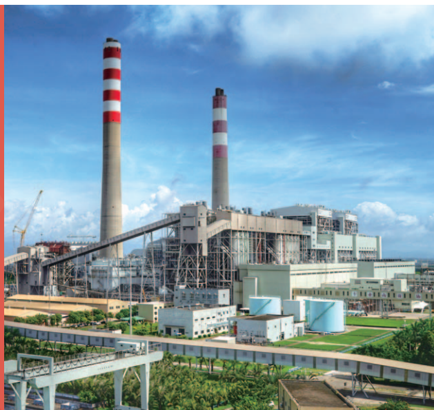
金灣發電廠增加了蒸汽量，並計劃進一步提高產量。
