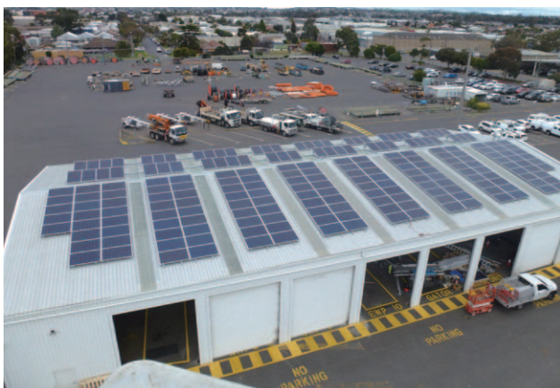
Powercor 在倉庫的屋頂安裝太陽能板，減少碳足跡和碳排放。
