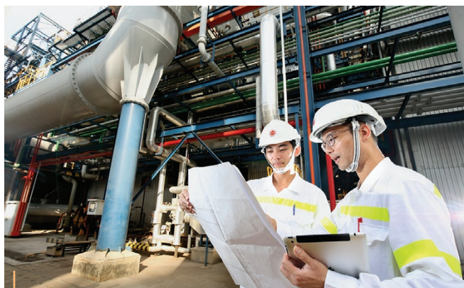
公司定期進行預防性的維修保養，以確保可靠供電。
