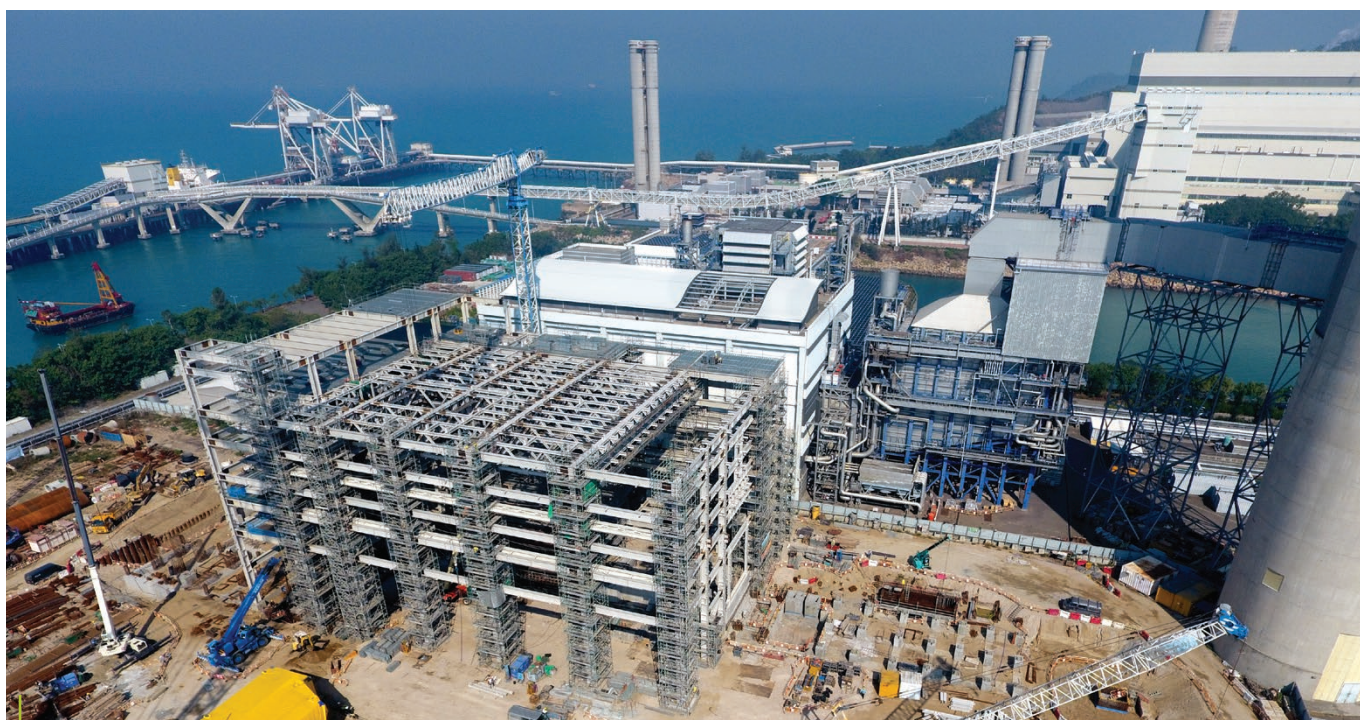
在南丫發電廠興建中的新燃氣發電機組。
