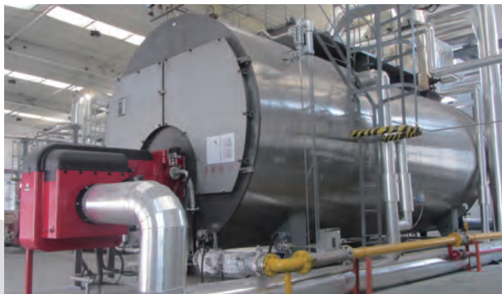
廢棄物回收重用 Waste recycle and reuse
