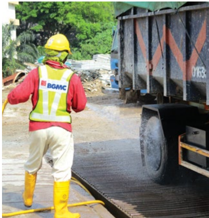
洗車間為重型車輛提供了快速且有效的清洗，因而不至於把泥濘和淤泥帶出工地。
