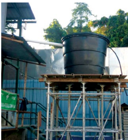
利用簡單的搭建採集雨水，用於工地活動中耗水量最大的一般清洗活動。
