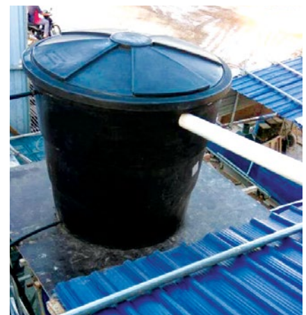
利用簡單的搭建採集雨水，用於工地活動中耗水量最大的一般清洗活動。
