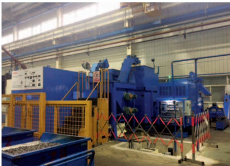
鐵屑處理及集中供油系統
