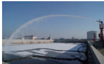
10萬立方米事故緩沖池及配套收集系統
