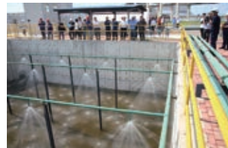
10萬立方米事故緩沖池及配套收集系統
