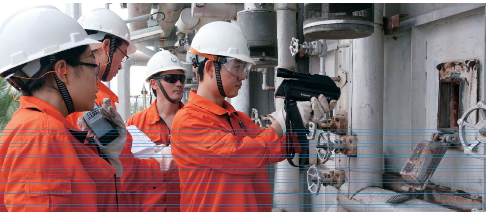
一段爐內溫度測量
