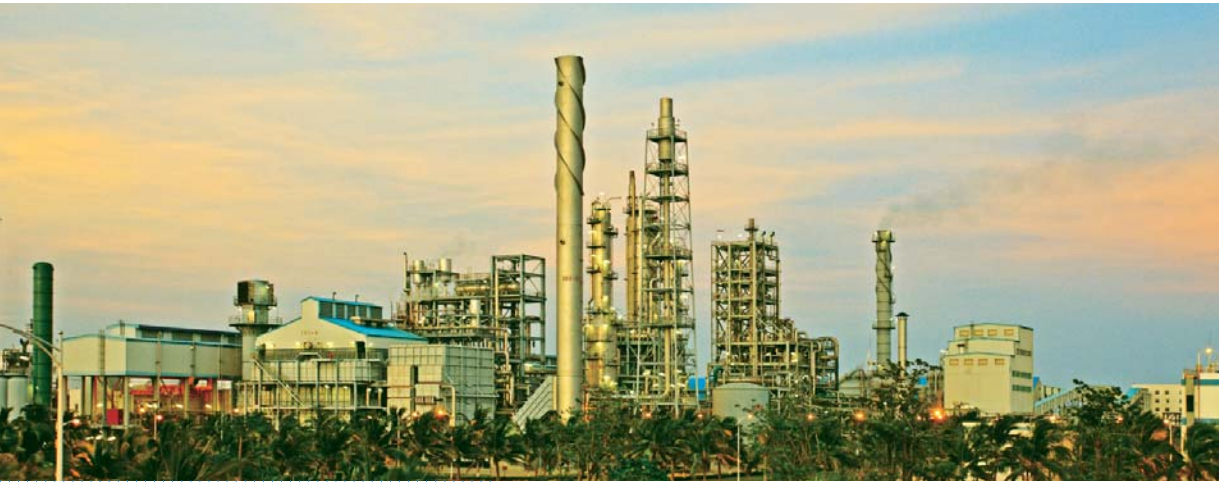
海南富島二期裝置
