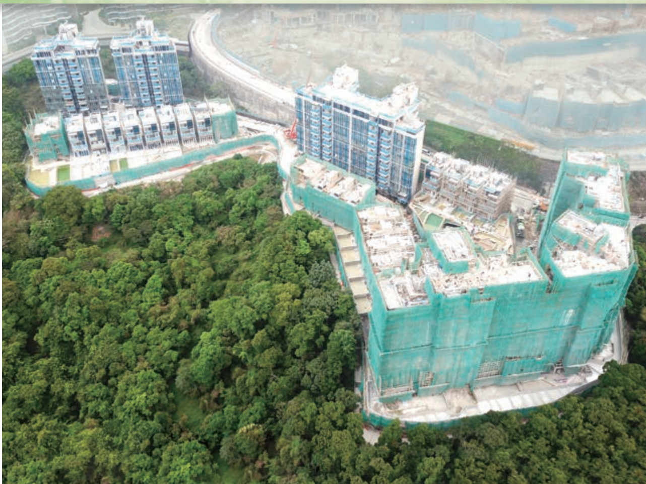
位於新界沙田九肚第56A區沙田市地段第578號之豪華住宅發展項目 — 上蓋建築工程進行中
