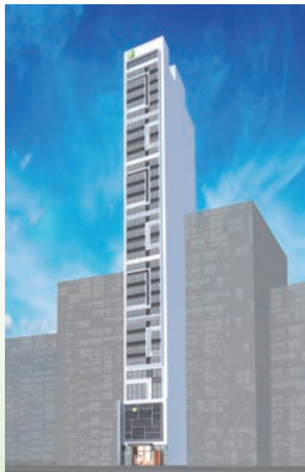
位於上環文咸西街5至7號及永樂街169至171號將予命名為「富薈蘇豪酒店」一上蓋建築工程進行中 (*)
