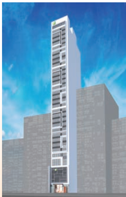
位於上環文咸西街5至7號及永樂街169至171號將予命名為「富薈蘇豪酒店」— 上蓋建築工程進行中 (*)
