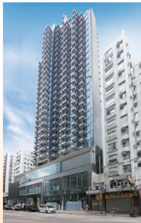
尚都 — 位於九龍深水埗順寧道 83 號之商業 / 住宅發展項目 — 已獲發入伙紙
