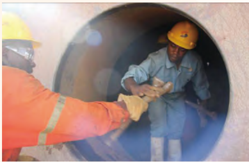
酸浸攪拌罐檢修清洗
