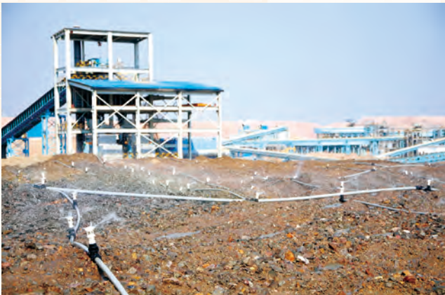
Muliashi項目堆浸系統1號堆場噴淋作業
