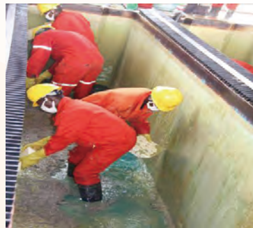
電積槽檢修清洗
